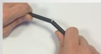
Faire une seule et légère coupure circonférentielle dans la gaine du câble (à 5 cm environ). Pour éviter (absolument!) toutes coupures des fibres à l'intérieur du câble, finir de détacher la gaine en pliant le câble à plusieurs reprises.
